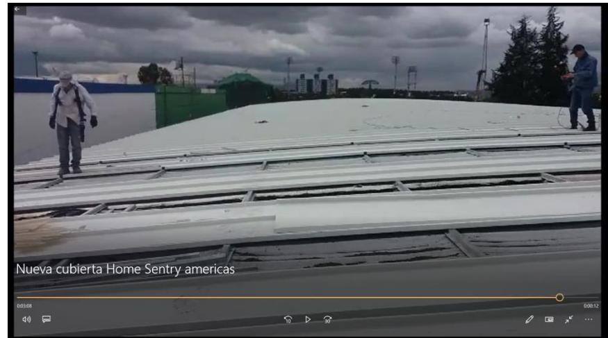
Estado Final de Cubierta –Home Sentry Américas
