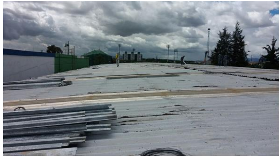
Estado Inicial de Cubierta –Home Sentry Américas
