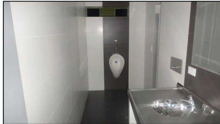
BATERIA DE BAÑO TERMINADA
