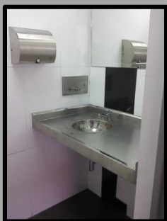
REMEDIACIÓN BAÑOS EDS TERPEL
